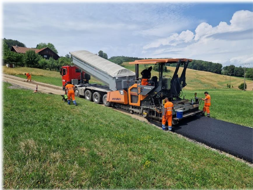
Pose de l'enrobé au Ch. de la Corbessière
