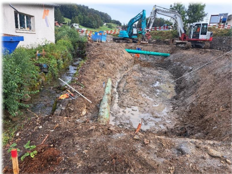
Chantier « Renaturation du Forestay et du Longiron » - Secteur Vulpillière
