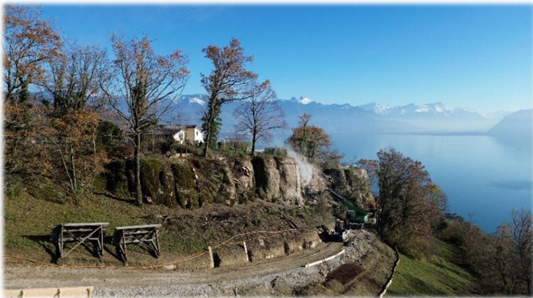
Piste d'accès au chantier
