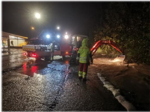
Intervention du SDIS sur le ruisseau du Longiron au Vergnolet
